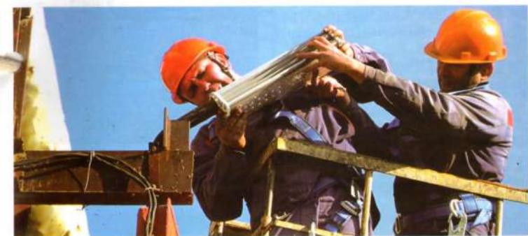
Установка светильников на территории завода
